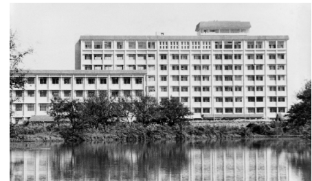
即将竣工的教学大楼 摄于1984年9月初
