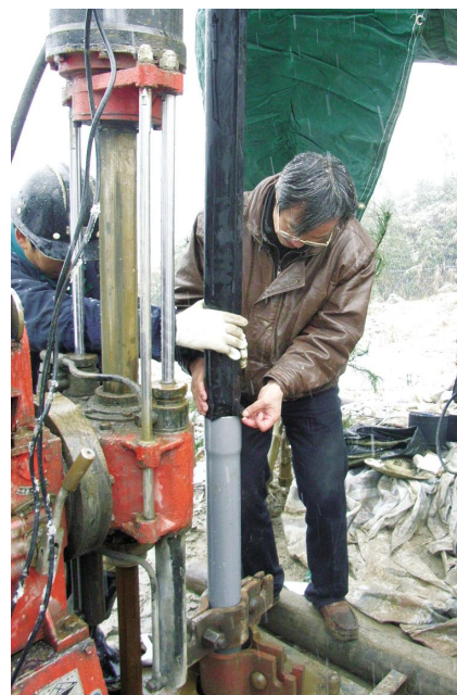
李青在施工现场放置地下位移传感器入地
