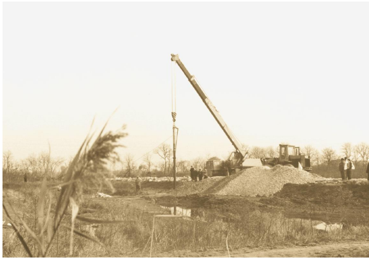
打下下沙新校区第一桩
