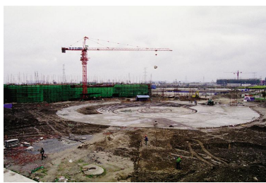
启明广场施工进行中
