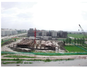
建设中的明德楼
