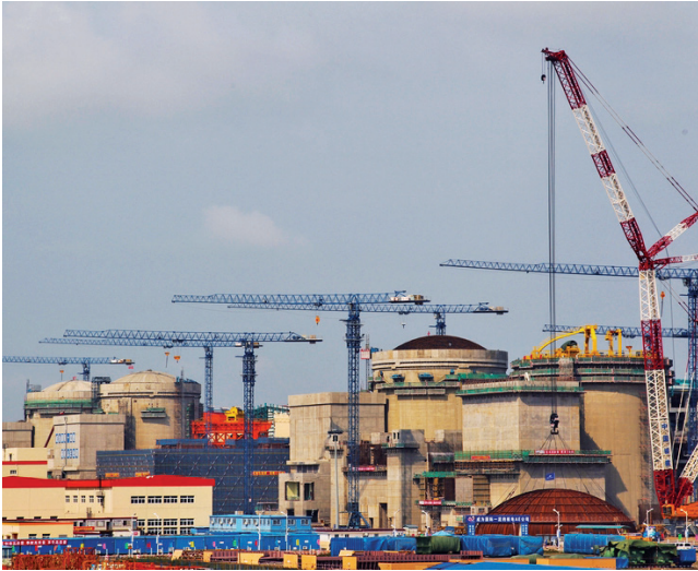
建设中的红沿河核电站
