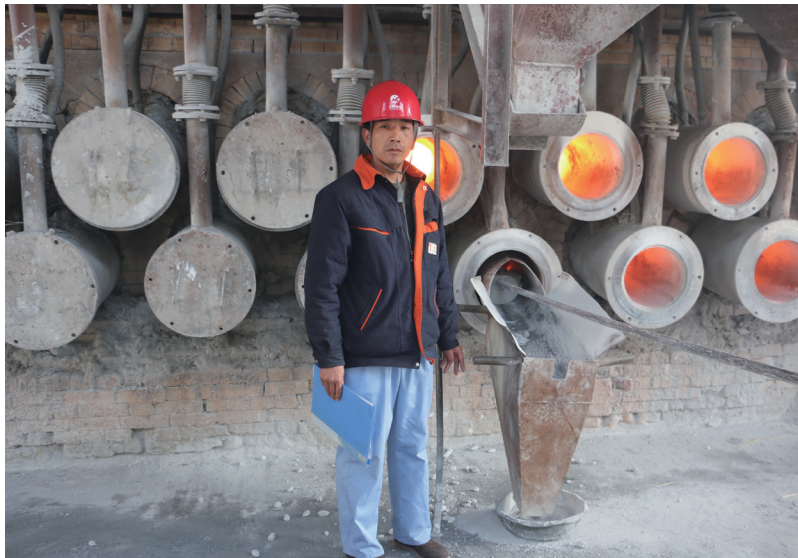
许杰忠的带回收料斗的装料筛，实现了粉料的回收利用
