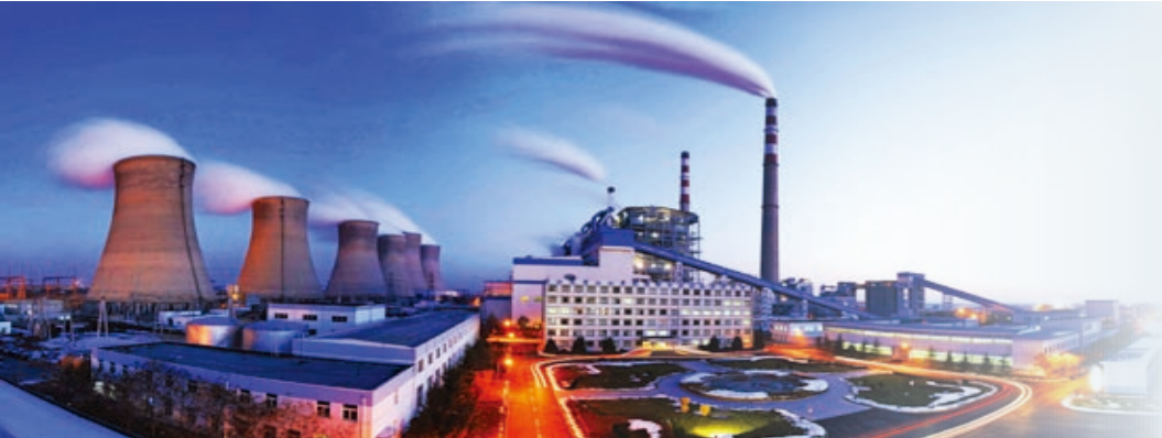
■山东新泰—华能众泰电厂 冷凝余热回收
