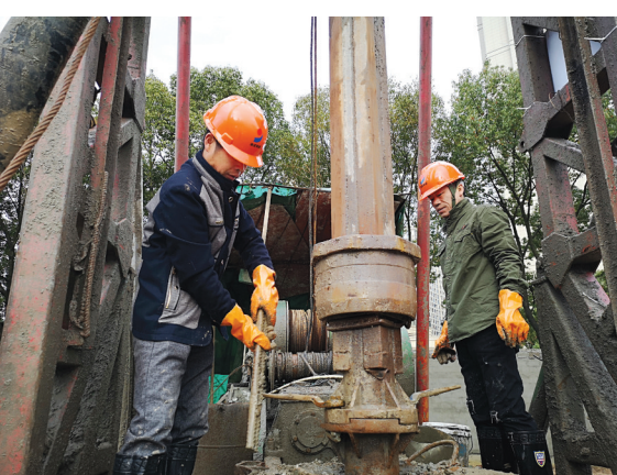
2019年3月6日,改扩建工程打下住院综合楼第一根桩基。
